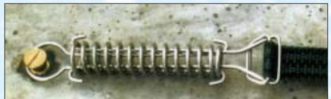
Upevnění plachty Flush Fix napínákem a hmoždinkou. Flush fixing with stretcher and dowel.
